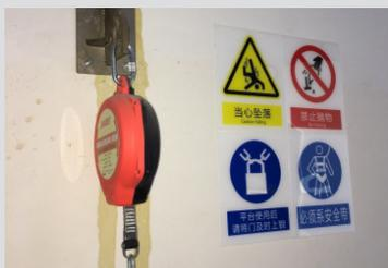
承包商平台進行作業吊裝活動時，人員使用固定長度安全帶在平台內工作時會有較多不便，由於人員需要頻繁移動，做到合規執行有一定難度。通過在平台處安裝差速器進行安全帶的掛靠，可以使員工在安全的條件上更便利工作，確保合規安全。
